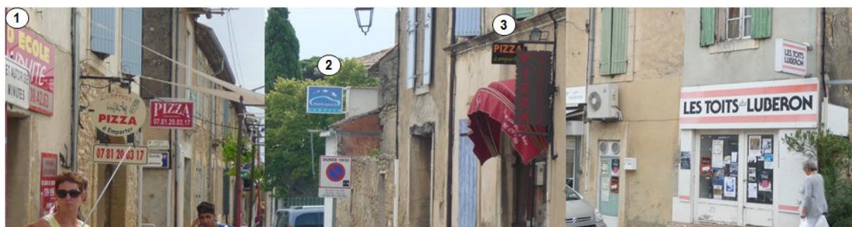
Enseignes en infraction du centre ancien de Lauris
